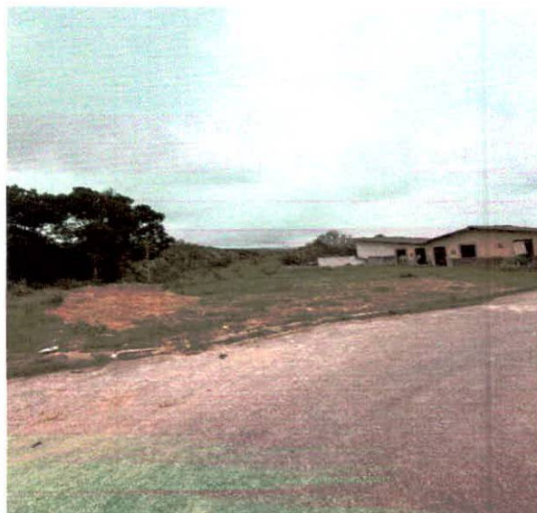
Imagem 02 – Area desocupada - Rua Nova ( Residencia que foi demolida e idenizada)
